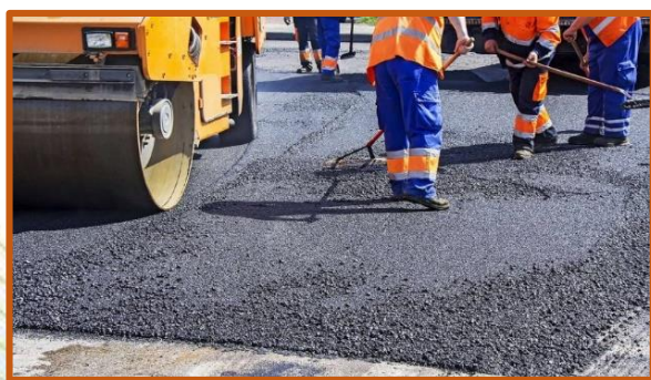
Рисунок 2 – Технология укладки обычного асфальтобетона
