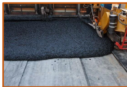
Рисунок 3 – Технология укладки литого асфальтобетона
